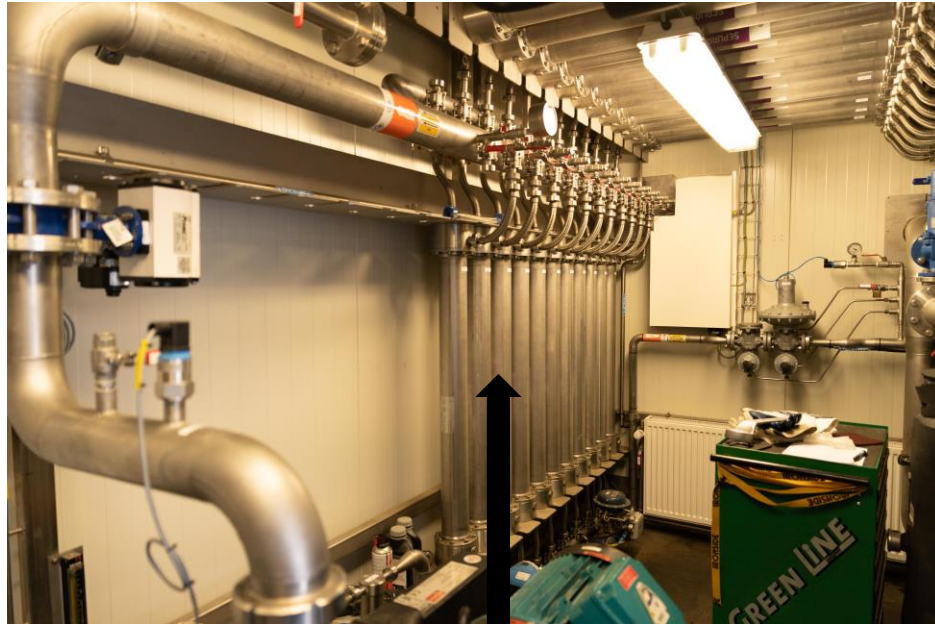
Membranisuodattimet rinnakkain
