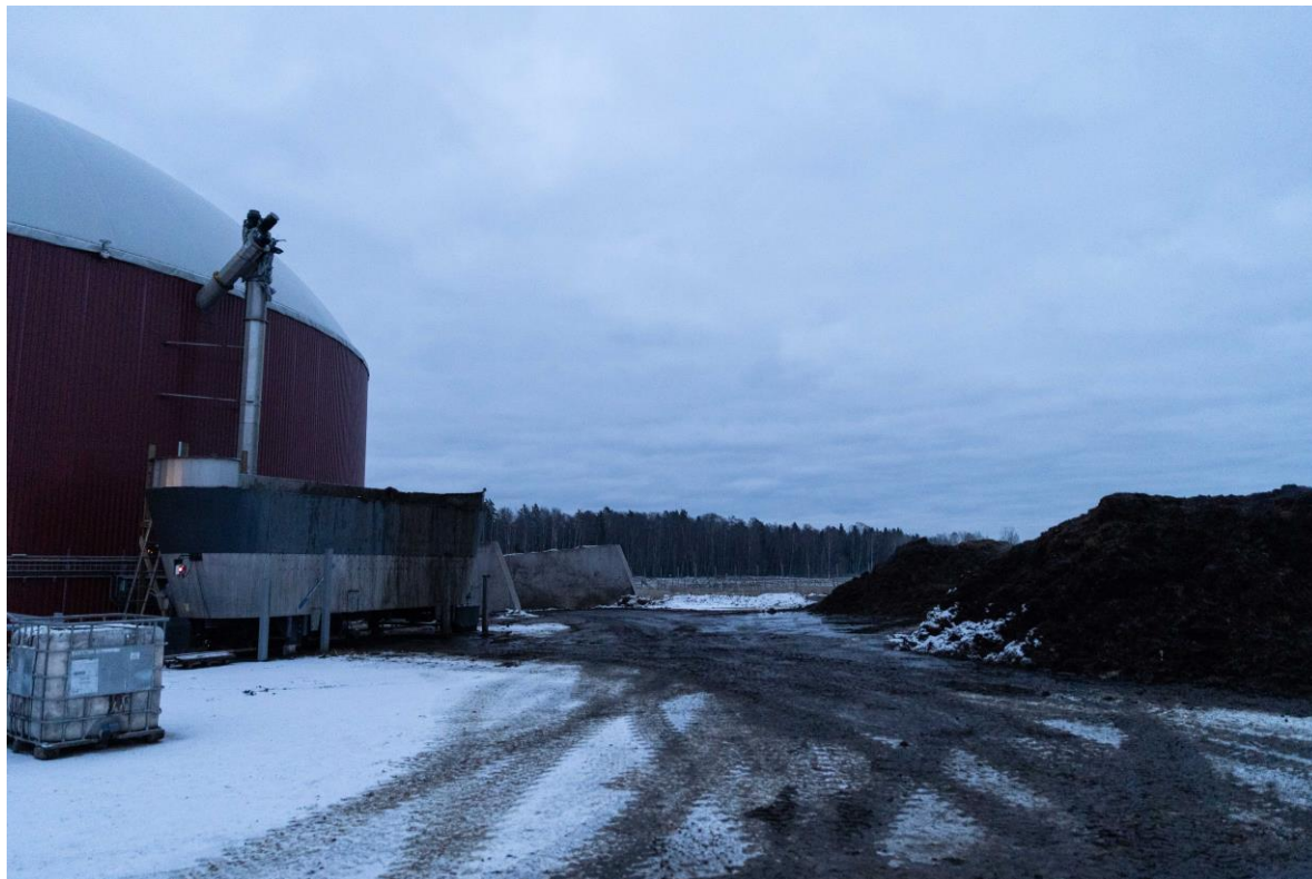
Biokaasulaitoksessa hyödynnetään lietteiden lisäksi kuivia jakeita, kuten nurmea ja kuvassa näkyvää kuivalantaa.
